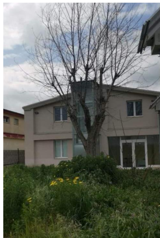
Nelle foto alcune immagini della villa affidata al consorzio Opus di Foggia.
