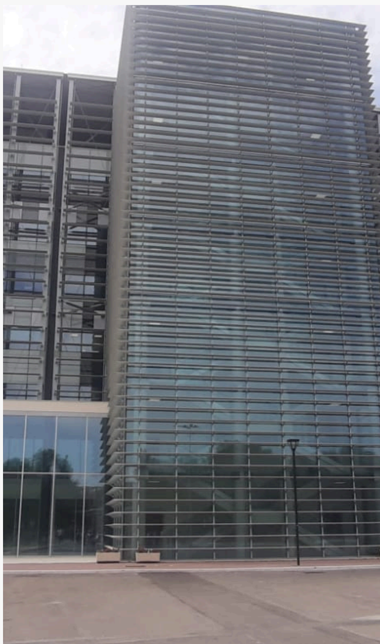
Una delle strutture del Policlinico di Foggia
